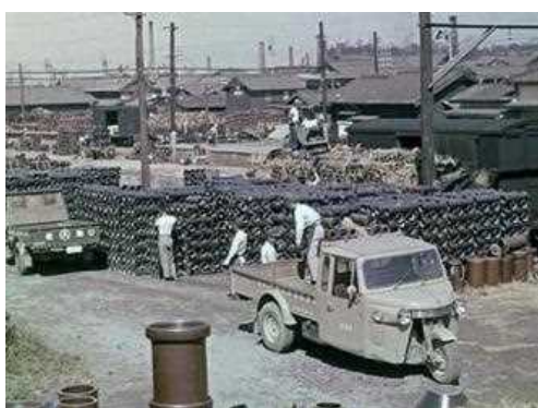
常滑駅構内の貨車積み込み 1961（昭和36）年
