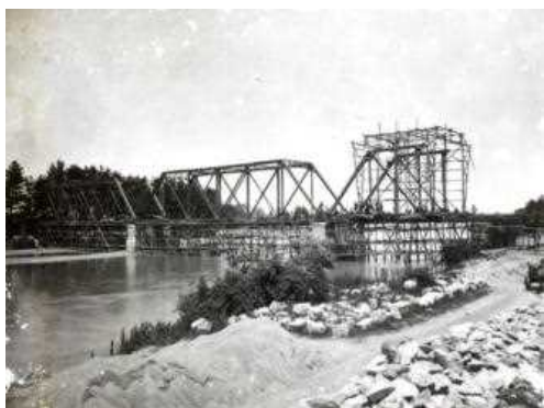
建設中の旧庄内川橋梁 明治45（1912）年
