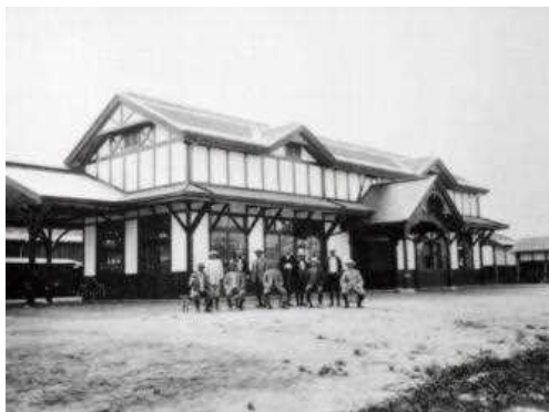
開通当時の岩倉駅 大正元（1912）年
