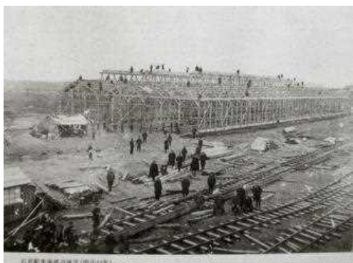
岩倉駅車庫建設風景 明治44（1911）年
