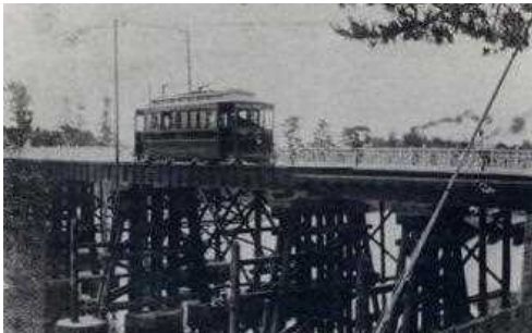
殿橋専用橋 大正時代
