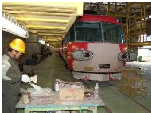
7001号の原形復元工事 舞木検査場 2008 (H20) .11.4
